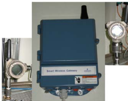
Figur 3-9 Trådløst utstyr som brukes i prosjektet, til venstre TT04101B, i midten GW1 og til høyre PT04003B.
