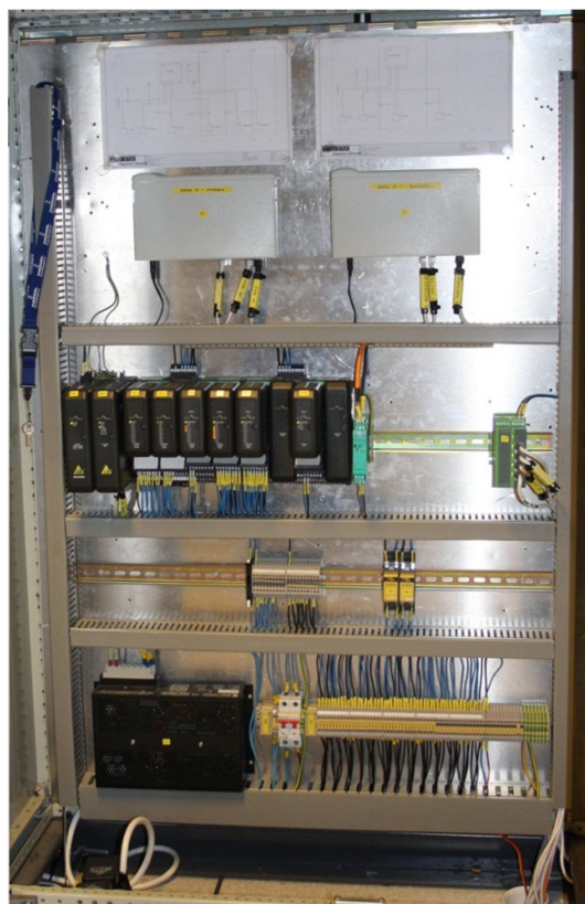
Figur 4-1 Skap 4100 er kabinettet som inneholder selve DeltaV systemet.
