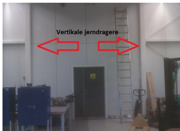
Figur 9-2 Vertikale jerndrage i prosesshallen hvor rørseparatoren skal festes.
