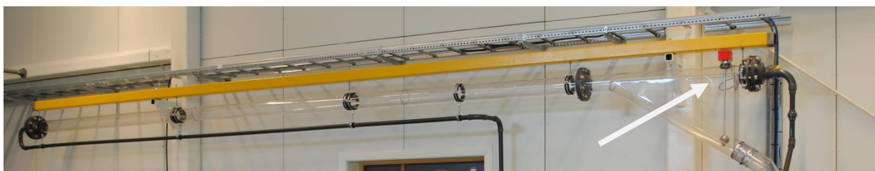
Figur 6-1 Førstetrinnsseparator med utløp og nivåtransmitter i enden.
