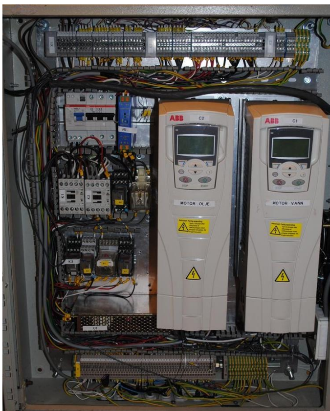
Figur 8-3 Koblingskap på flerfaserigg, uten deksler til kabelgatene
