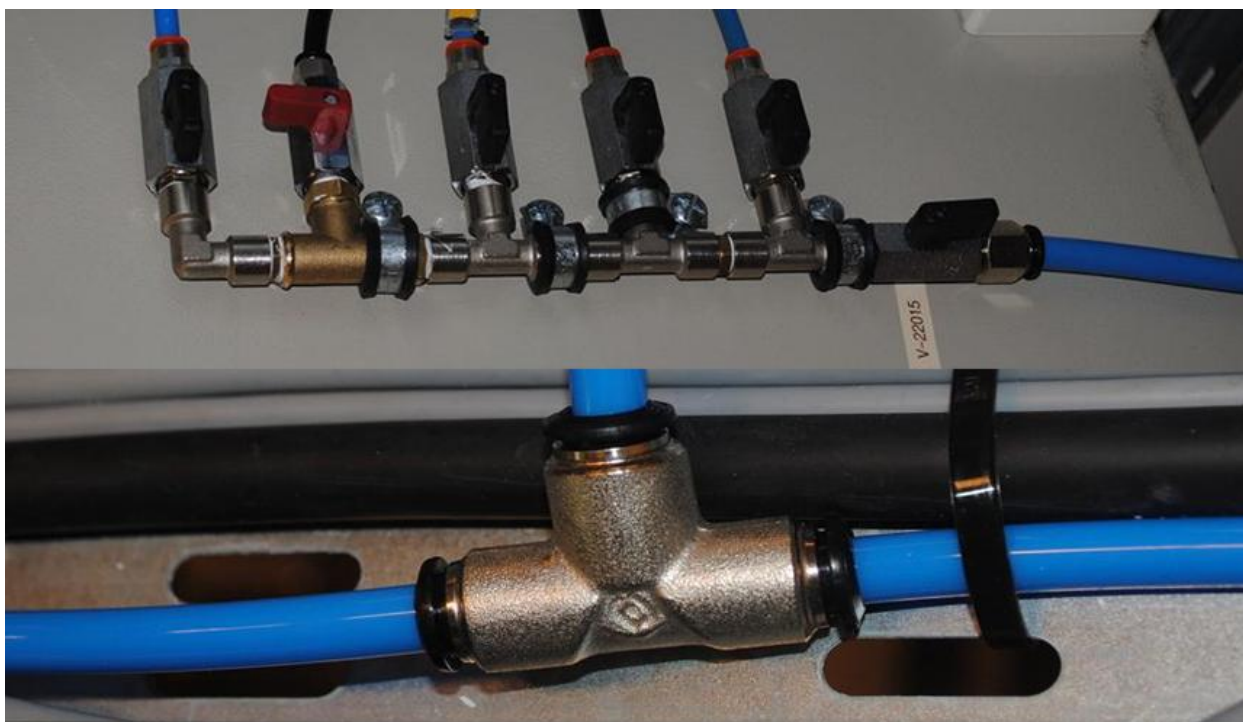
Figur 8-5 Luftkilde og luftsplitter som forsyner reguleringsventiler
