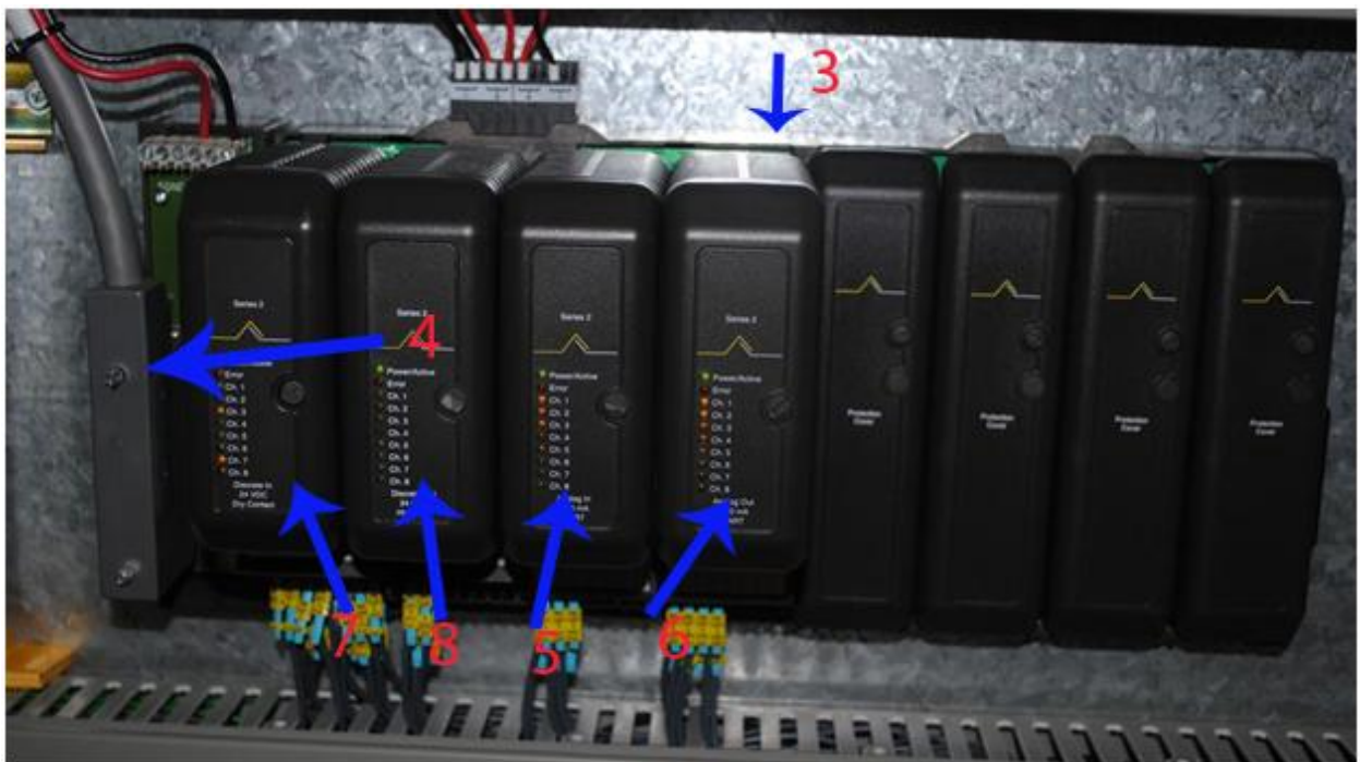
Figur 8-2 DeltaV kort på 8-wide med tilkoblingskabelen. Med punkter til forklaring
