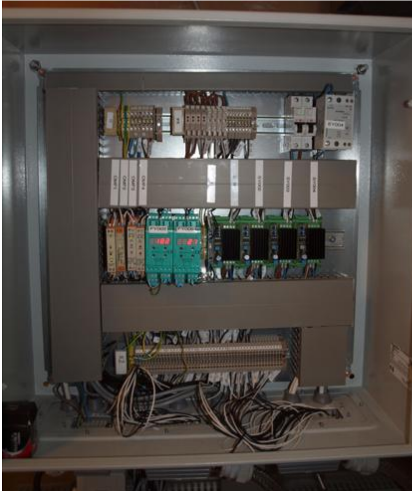
Figur 4-3 Koblingsskapet på riggen
