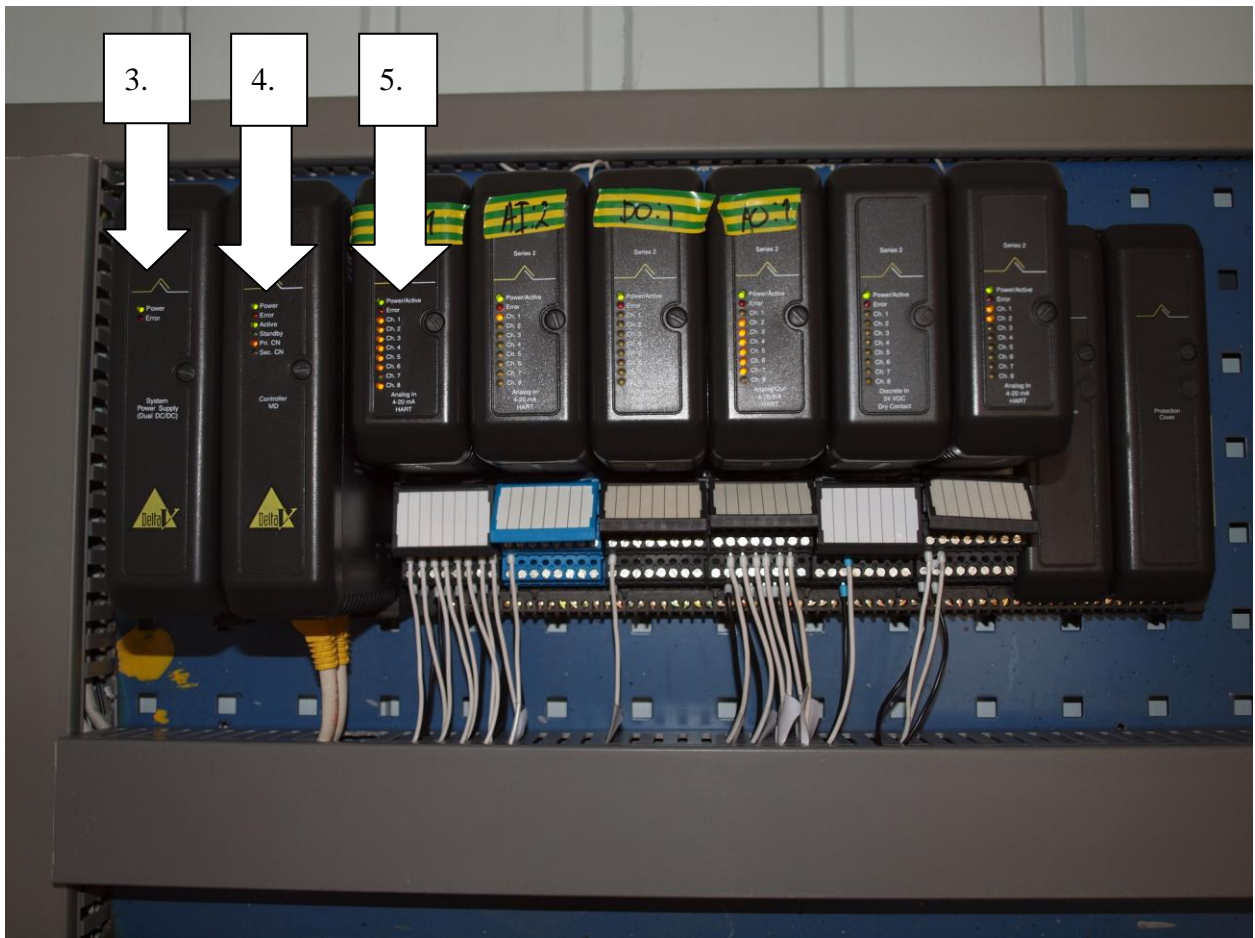
Figur 10-2 DeltaV-kontroller med I/O-kort
