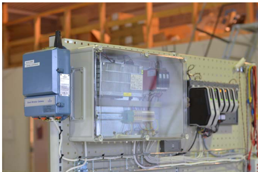
Figur 3-2 Emerson Wireless Gateway montert på opplæringsrigg.
