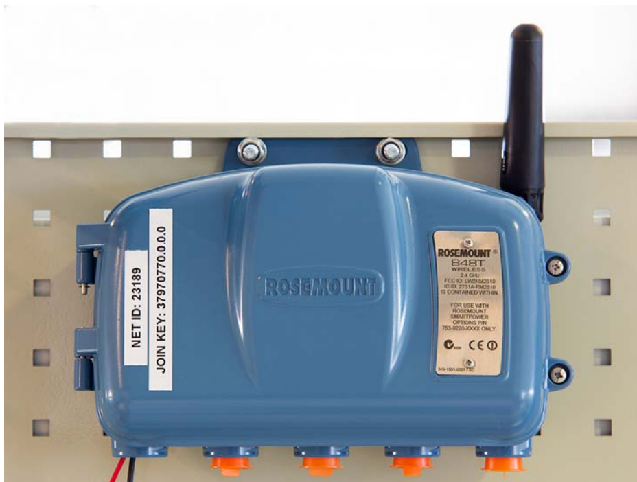
Figur 3-5 Montering av Rosemount 848T på opplæringsrigg.
