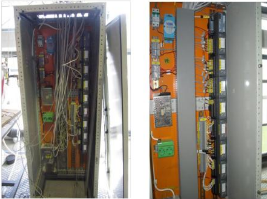
Figur 2-2 Skap 4300, før og etter oppgradering. NI-blokkene er plassert på høyre side i skapet.
